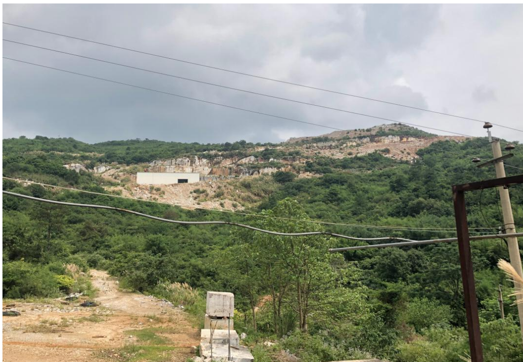
矿山现场勘查图 1
