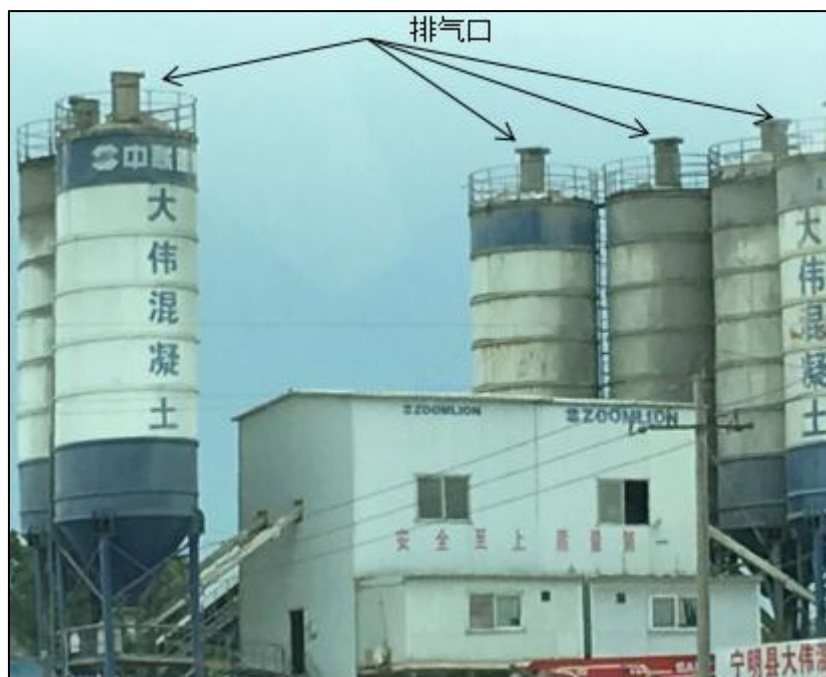
图 3.2-1 混凝土拌合楼、筒仓示意图
